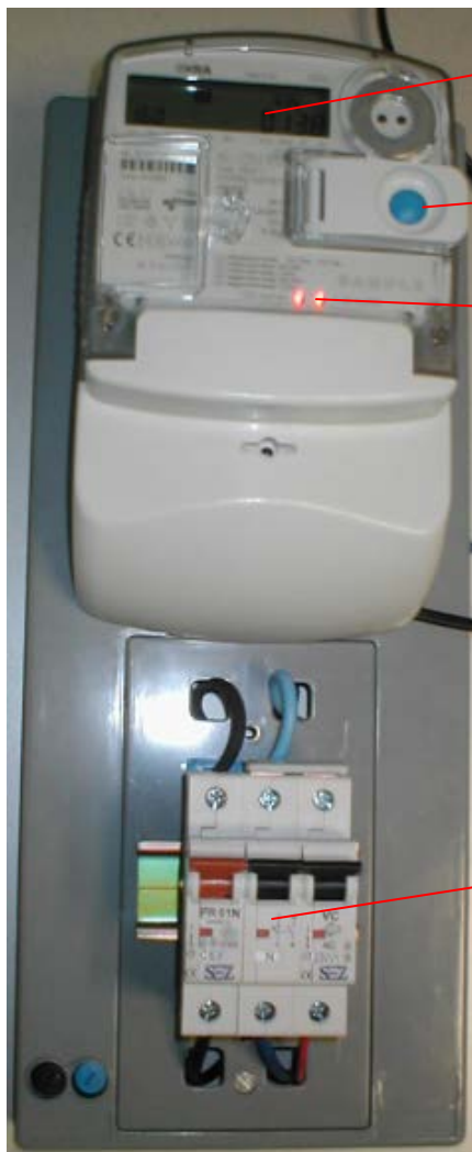
Bild: Wechselstromzähler ME371 mit Schutzschalter zur Leistungsbegrenzung
